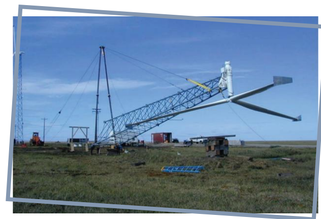
Установка в Уэльсе без применения крана ветротурбины с инновационной конструкцией наклонной башни
