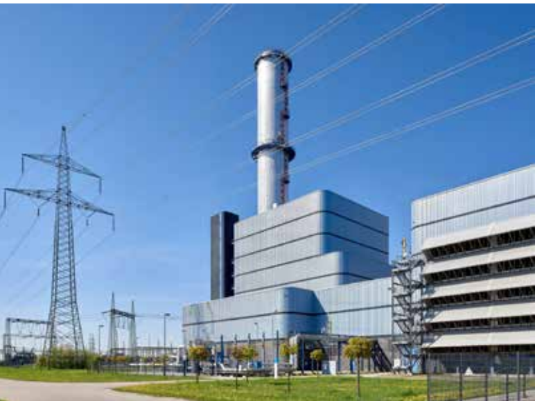
Газовые электростанции Irsching 4 и 5, Германия Источник: hodmysley.ru
