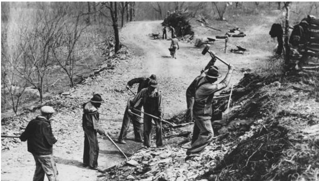
Строительство новой дороги в Теннесси в период Великой Депрессии, 1936 г.
