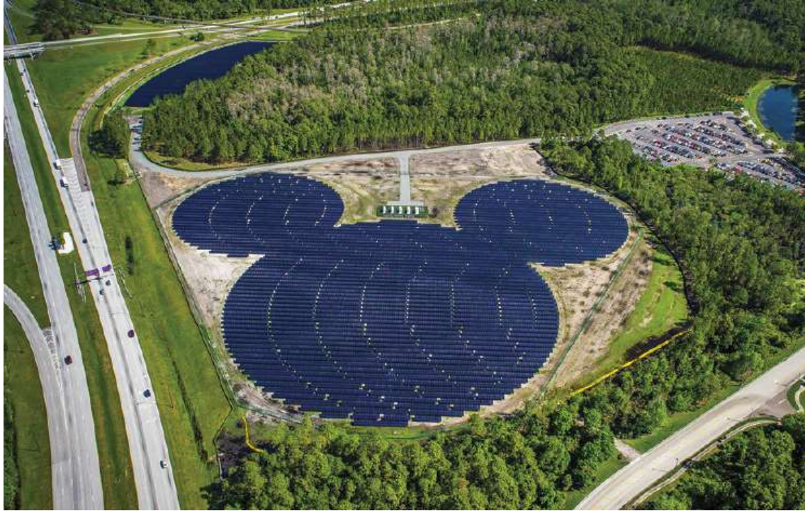
Солнечная электростанция Duke Energy во Флориде, обеспечивающая энергией корпорацию Disney в Орланд. Источник: Southern Alliance for Clean Energy
