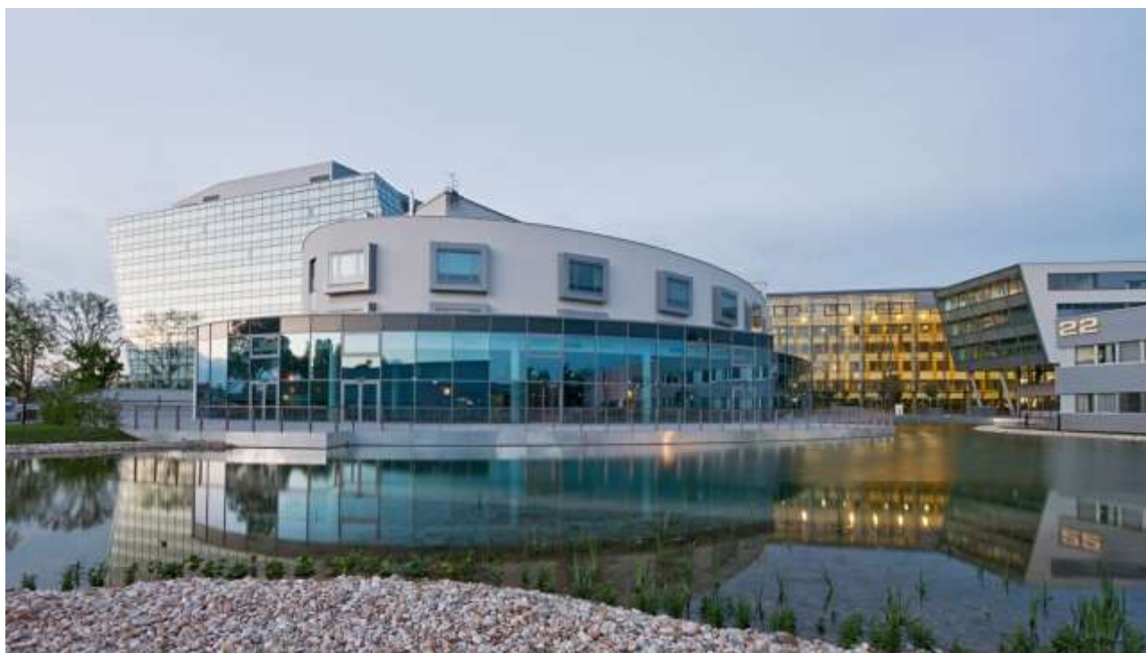
Здание Siemens Campus с интегрированным микрогридом в Вене (Австрия). Источник: Siemens
