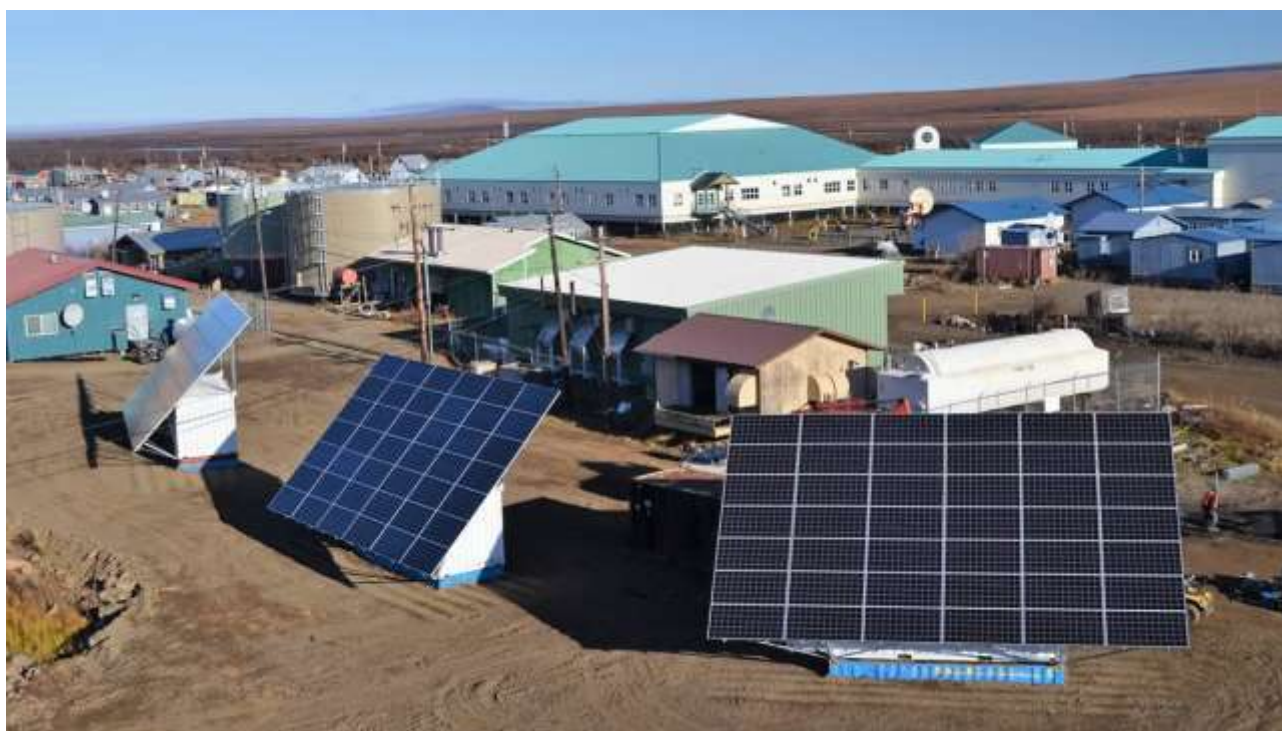
Модульный контейнерный микрогрид в Бакленде (Аляска, США). Источник: VoxPower
