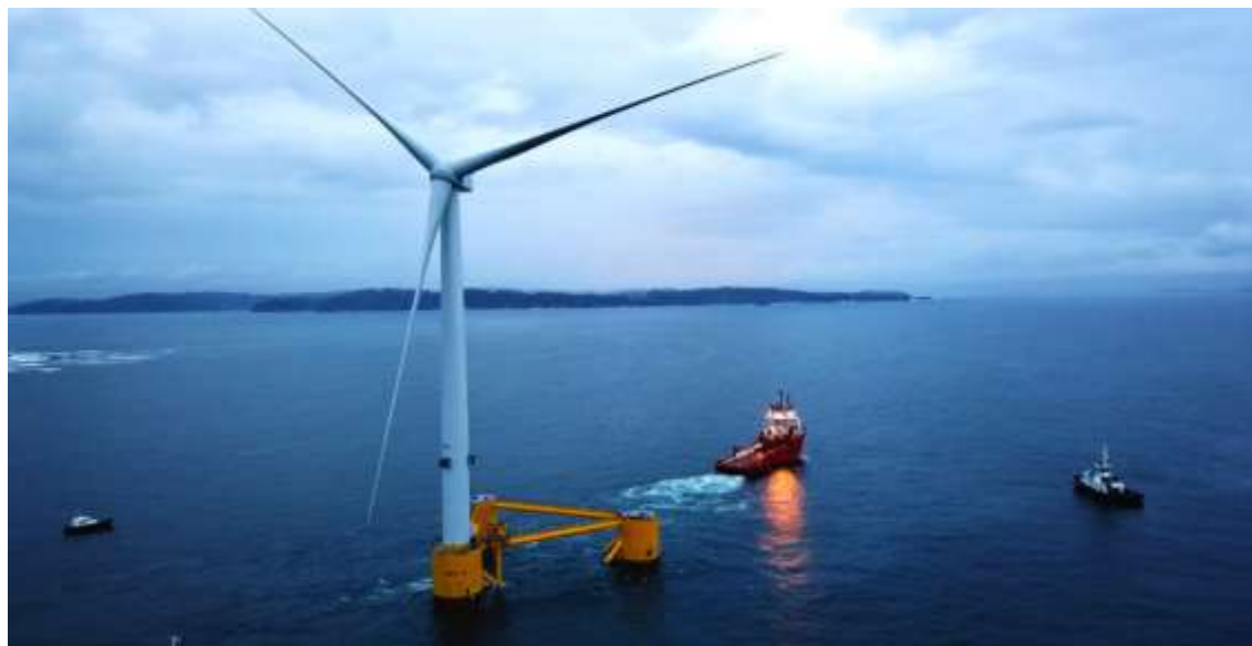
Плавучая ВЭС Vestas 8,4 МВт в рамках проекта WindFloat Atlantic
